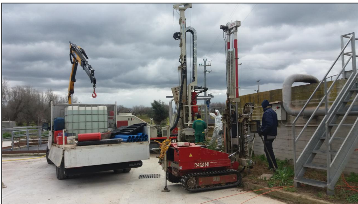
Foto 12. Esecuzione del sondaggio penetrometrico DPSH8.
