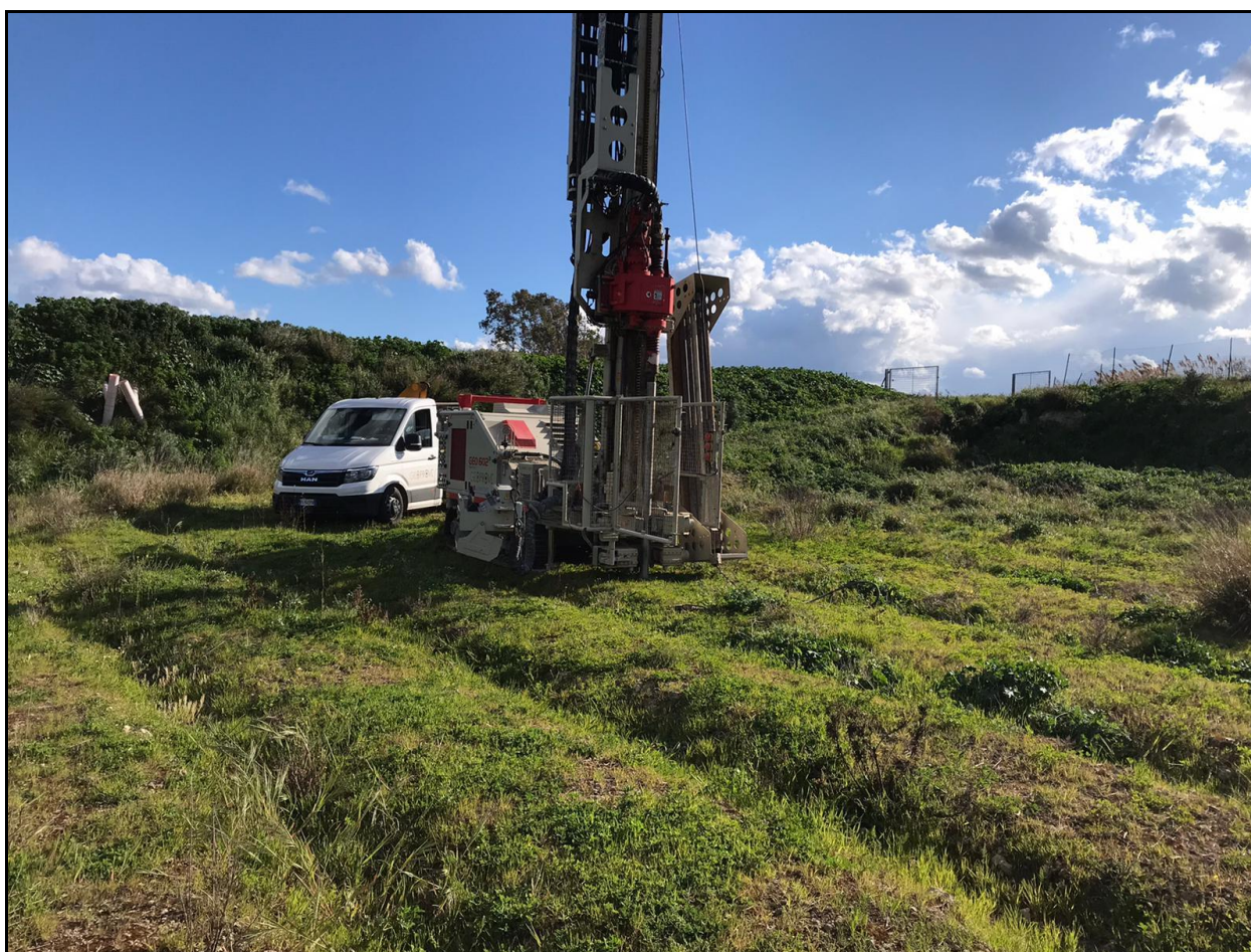
Foto 18. Esecuzione della prova di permeabilità in foro PE6.
