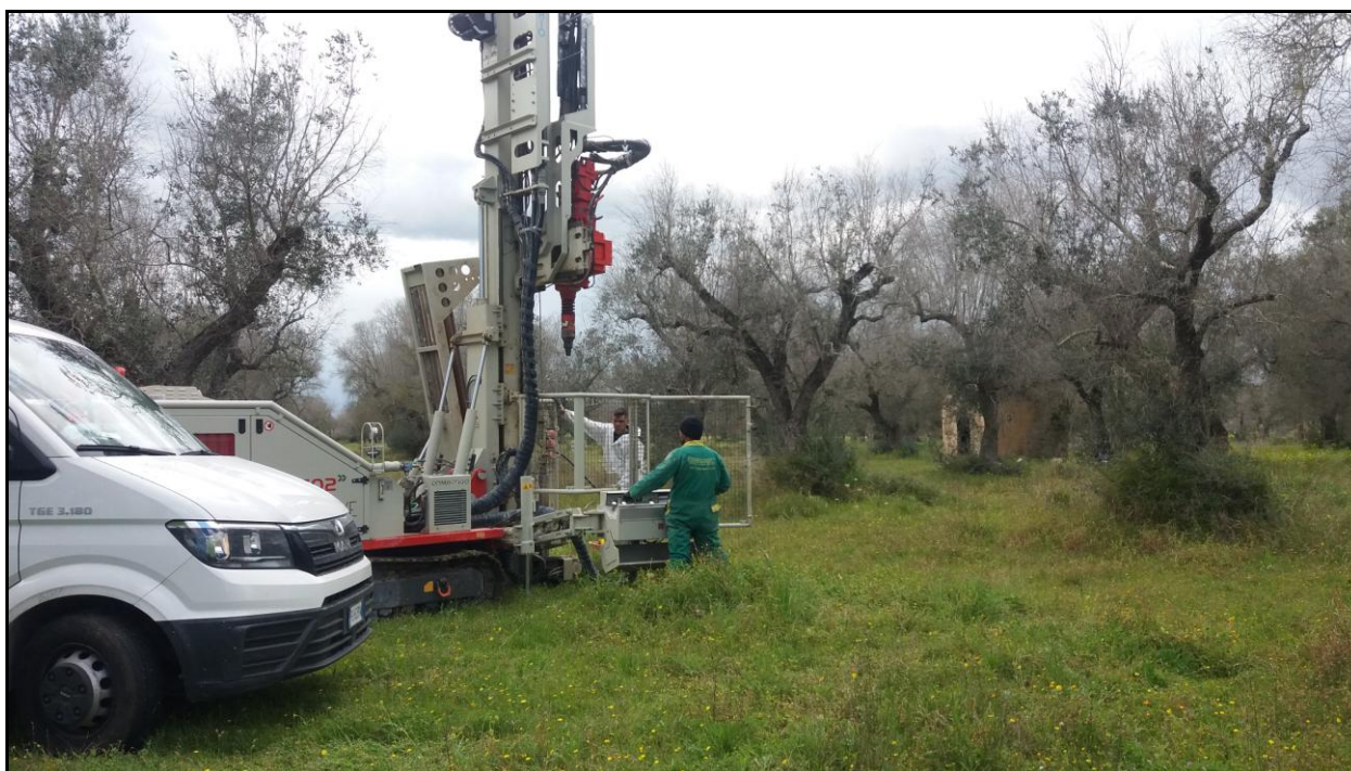
Foto 15. Esecuzione della prova di permeabilità in foro PE3.
