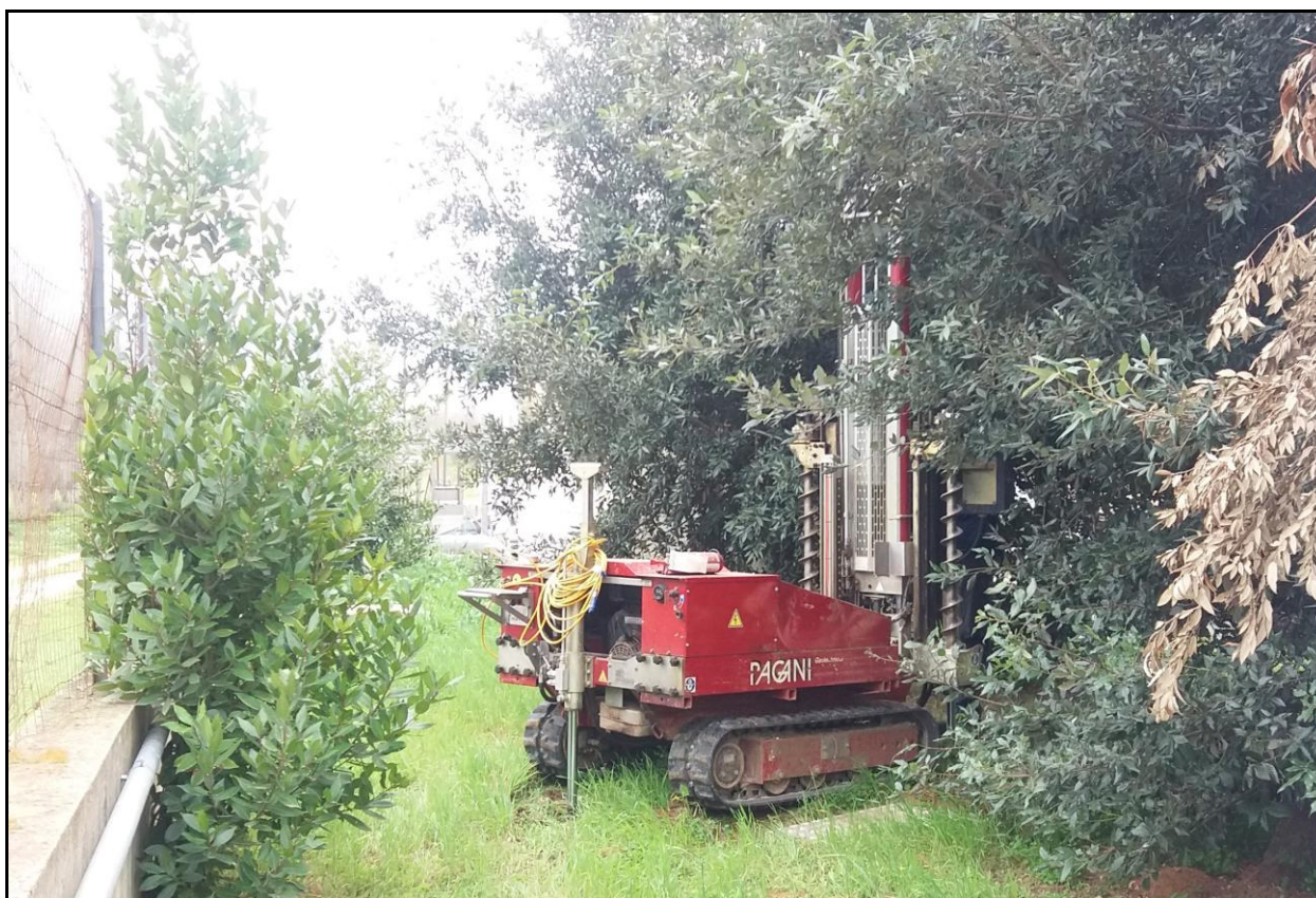
Foto 11. Esecuzione del sondaggio penetrometrico DPSH7.
